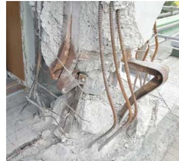
写真-2 3F 耐震壁側柱詳細
