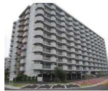
写真-1 被災建物
