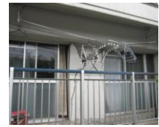
写真-2 被害概要 (方立壁)
