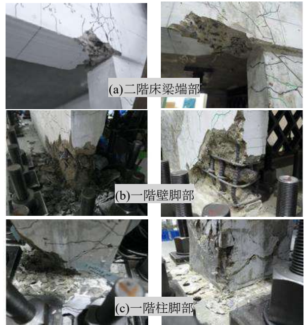
新設試験体 補修試験体 写真1 最終加振後の試験体の様子
