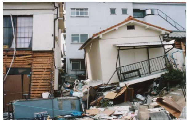
写真1 阪神淡路大震災で倒壊した住宅
