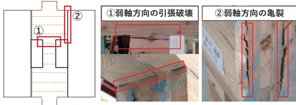
写真-1 CR-6 破壊部分の詳細
