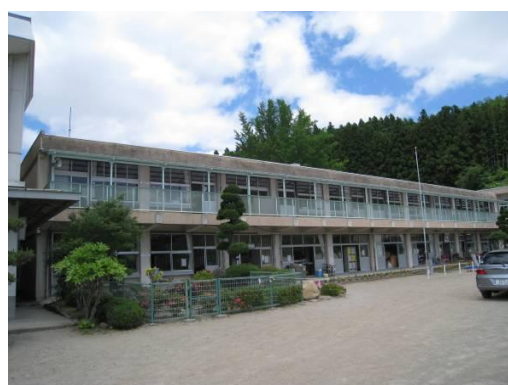
写真1 上野目小普通教室棟の全景
