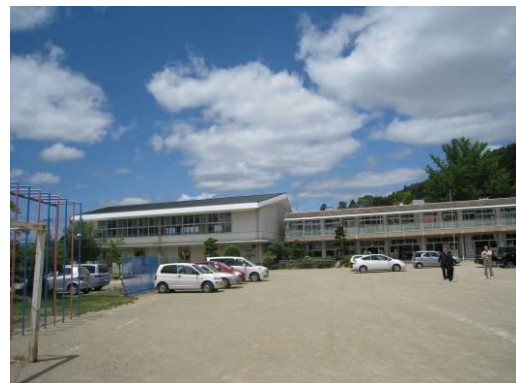
写真4 上野目小学校 屋内運動場の全景
