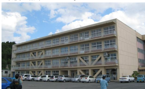
写真 12 栗駒中学校校舎棟の全景
