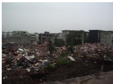
写真1 集合住宅が多数倒壊した街区（漢旺）
