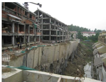
写真2 傾斜地に建設中の集合住宅群（都江堰）
