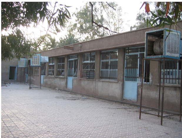
写真 6 平屋建の学校校舎 (大きな被害はなし)
