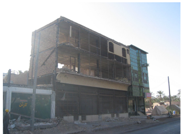
写真 8 建設中の店舗付き住宅の全景
