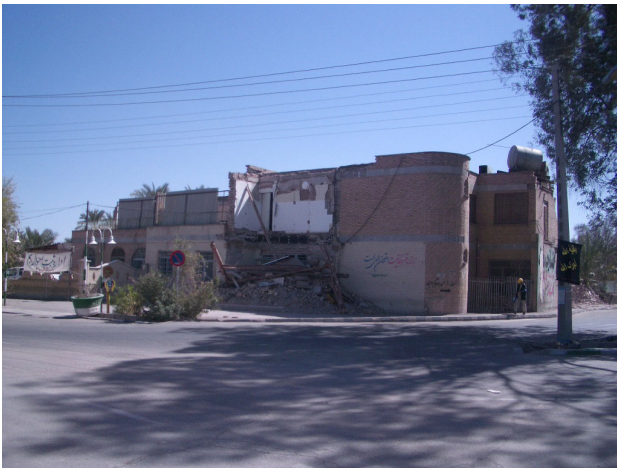
写真2 Governor's Building 北面
