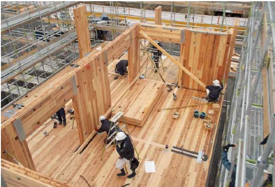
CLTパネル建て方の様子
