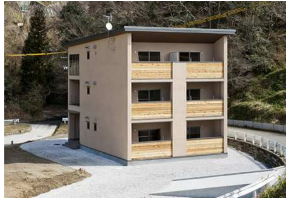
高知おおとよ製材社員寮(2014年3月) (日本で初めてのCLT工法建築物)
