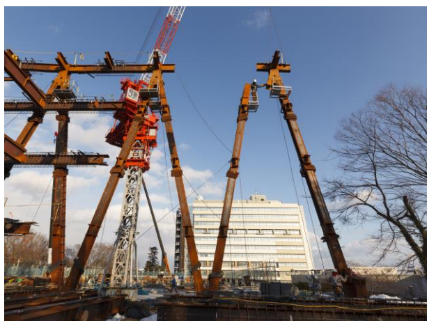
建設中の人間・環境系建物
