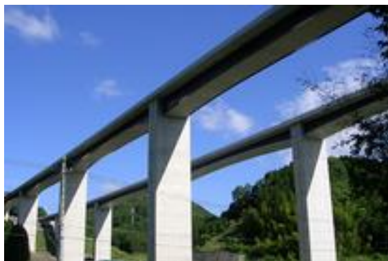
第二敬神高速道路の橋桁
