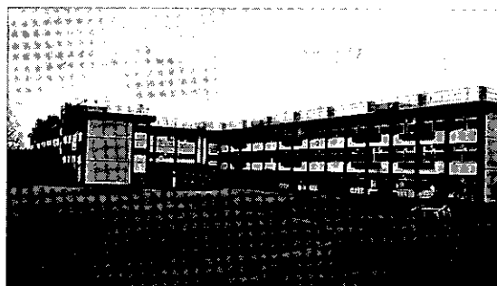
写真1 TH小学校校舎の全景
