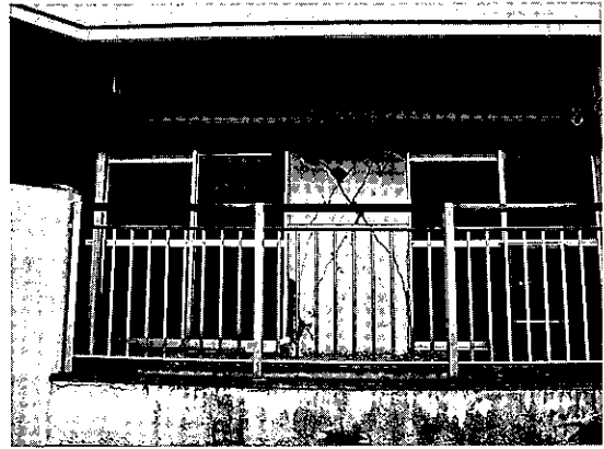
写真4 外側構面の2次壁のせん断破壊
