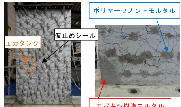
写真1 補修工事の状況（W4R試験体）
