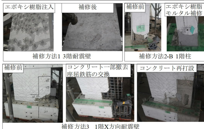
写真2 各方法による補修状況
