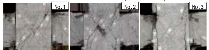
写真2 ひび割れ状況( R=1/25\text{rad} .)
