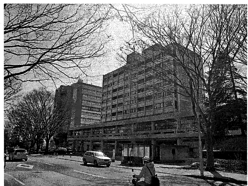
写真1 東北大学人間・環境系研究棟の全景
