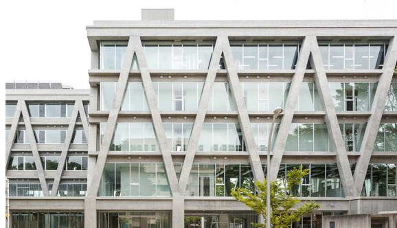
写真 5.1 人間・環境系教育研究棟の北面
