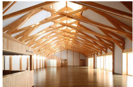
石田沢防災まちづくりセンター
