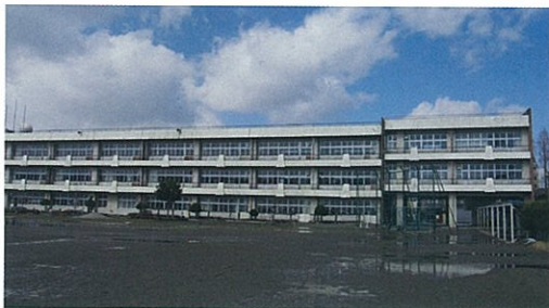
写真-6 杭基礎に損傷が生じて沈下傾斜した学校校舎
