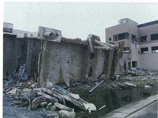
写真-10 津波で転倒した杭基礎のRC造建物
