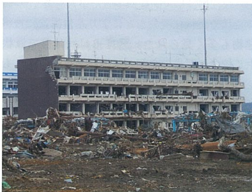
写真-7 3階まで津波で水没した校舎
