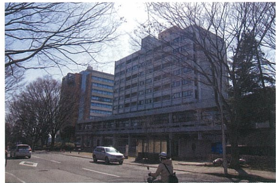
写真1 人間・環境系実験研究棟の全景
