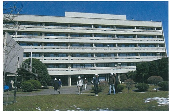
写真11 マテリアル・開発系実験研究棟の全景
