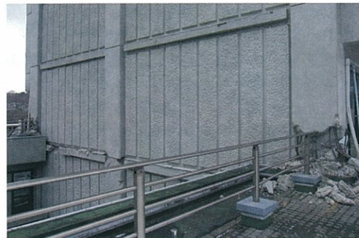
写真2 建物東側の耐震壁3階部分
