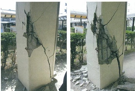
写真10 北講義棟の1階柱の破壊状況 (左は3月11日の本震後、右は4月7日の余震後)
