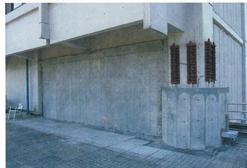
写真4 応急補強(柱脚部のコンクリートと壁を新設)
