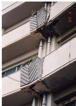
写真 8 せん断破壊した柱 写真 9 Exp. Joint の被害
