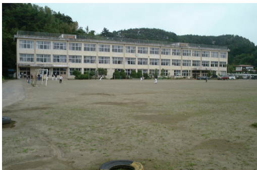
写真 14 野蒜小学校校舎の全景
