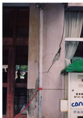
写真 10 せん断破壊した柱 写真 11 コンピュータ室の被害状況
