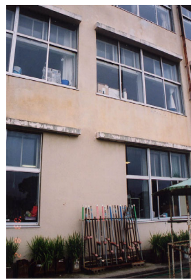
写真 15 袖壁補強した南構面の柱
