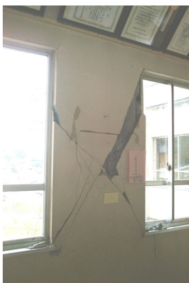
写真 8 せん断破壊した柱 写真 9 Exp. Joint の被害
