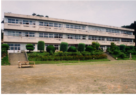
写真1 北村小学校校舎の全景
