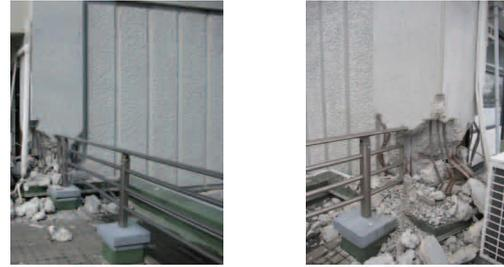
写真-1 柱の被害写真
