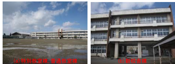
写真 2-1 校舎南側外観
