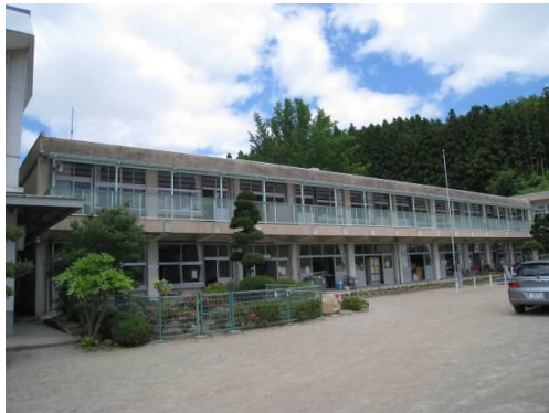
写真 12 上野目小普通教室棟の全景
