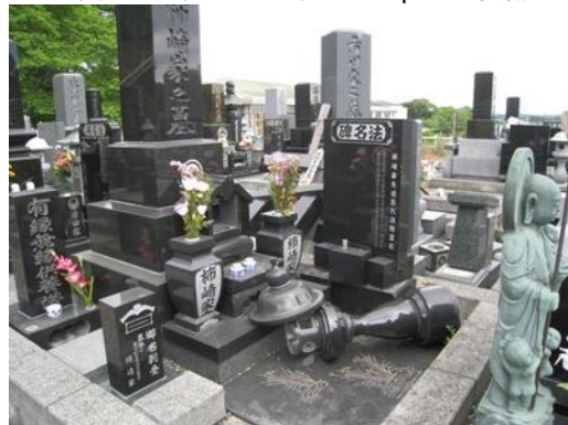
写真5 転倒した石灯籠（墓石の転倒はない）
