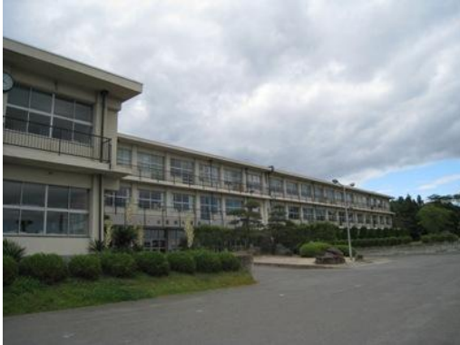
写真 6 築館中学校校舎の全景
