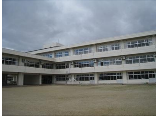
写真3 築館小学校校舎
