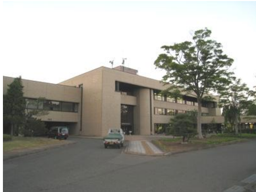
写真 11 奥州市胆沢総合支所の全景
