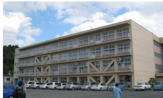
写真 24 栗駒中学校校舎棟の全景
