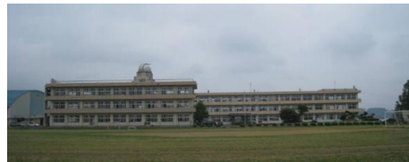
写真 18 岩ヶ崎高校校舎の全景
