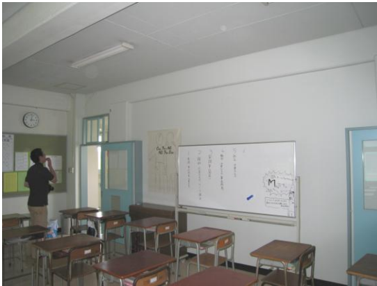
写真 25 教室の前後に出入口開口を設けた RC 補強耐震壁（開口脇に付け柱あり）
