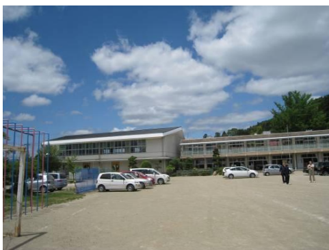
写真 16 上野目小学校 屋内運動場の全景
