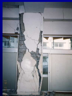
鉄筋は露出しているが、座屈や破断は見られない
