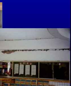
梁との境界部にひび割れが見られるが、壁鉄筋の変形は見られない
