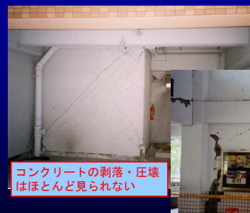
梁との境界部にひび割れが見られるが、壁鉄筋の変形は見られない
