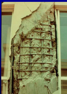
鉄筋は露出しているが、座屈や破断は見られない
