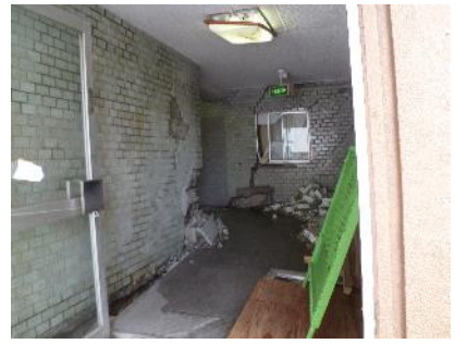
1階コア階段室内部
