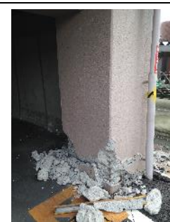
柱脚損傷部
