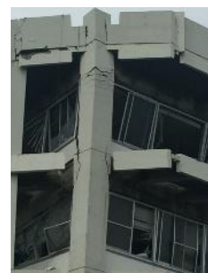
柱頭損傷部
