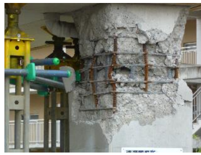
柱損傷部
