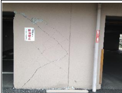
袖壁損傷部
