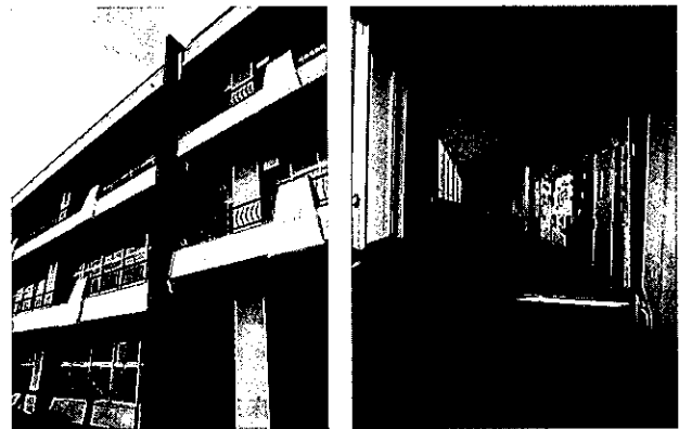
写真-19 校舎間に生じた段差 (F中学校)
