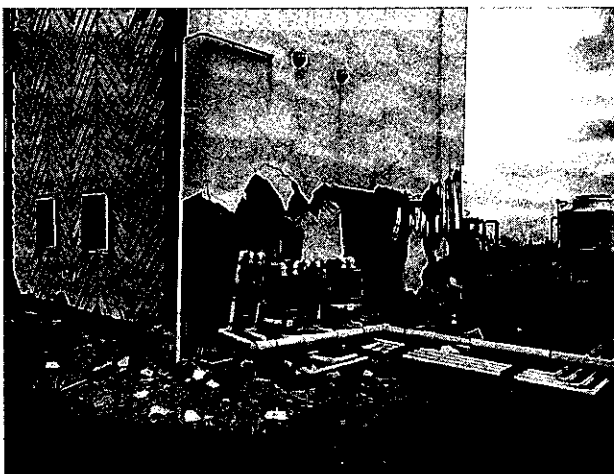
写真-8 大破したペントハウス (T大学D研究棟)
