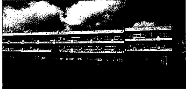
写真-17 F中学校校舎 (左:管理普通教室、右:新校舎)
