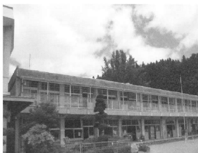
写真1 上野目小普通教室棟の全景
