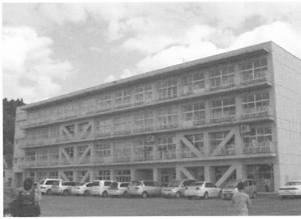
写真13 栗駒中学校校舎棟の全景
