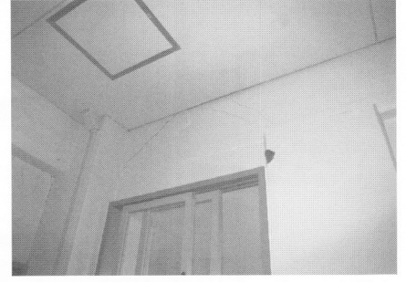
写真15 補強壁の開口上部の梁のせん断ひび割れ
