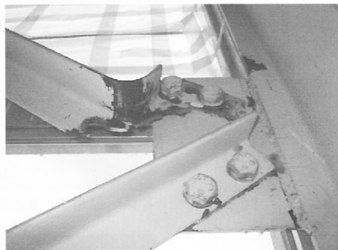
写真6 接合部におけるブレースの破断
