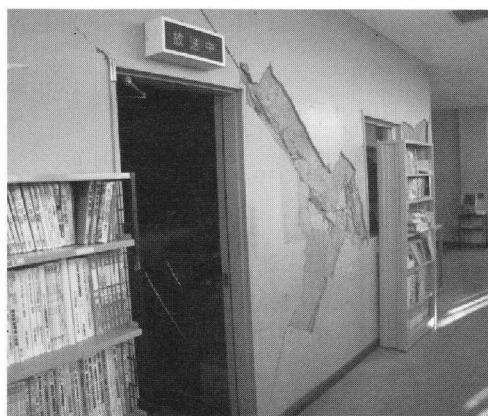
写真9 せん断破壊した壁 (損傷度Ⅳ)
