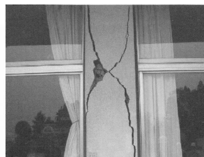
写真2 1階Y0-X6柱（損傷度Ⅳ）
