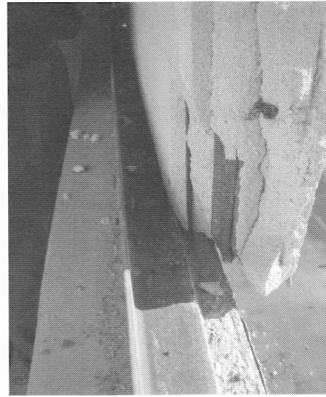
写真17 ALC版接合部（鉄筋溶接部が外れている）
