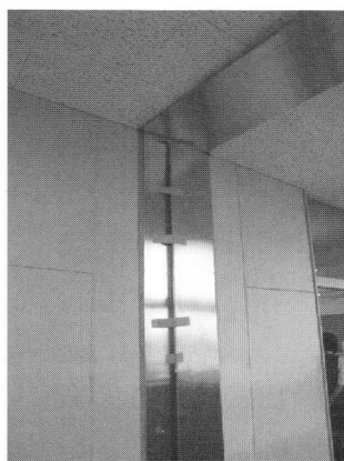
写真11 EXP. Jointカバーの損傷
