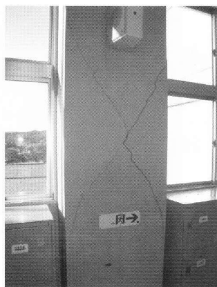
写真8 柱のせん断ひび割れ (損傷度Ⅲ)
