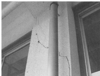
写真3 1階Y0-X8柱（損傷度Ⅲ）
