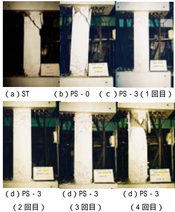
図 - 8 最終破壊状況
