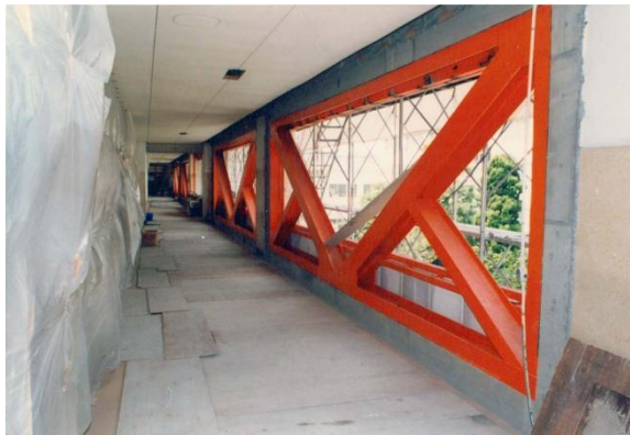
(a) 施工中の状況
