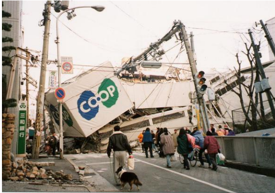
完全に倒壊した商業施設
