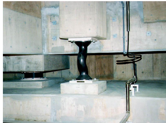
(a) 基礎免震により耐震改修された建物 (b) 免震装置(積層ゴム支承とダンパー)
