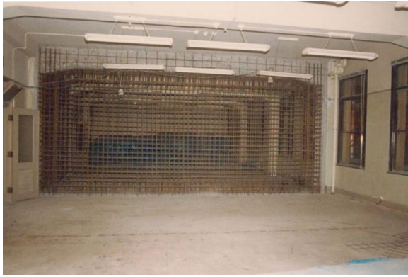
(a) 施工中の配筋の状況
