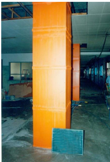
(a) 鋼板巻き立て補強
