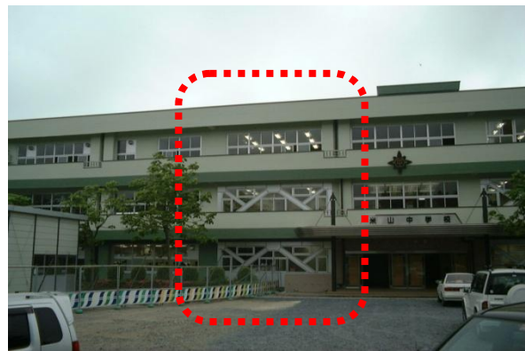
(b) 施工完了時
