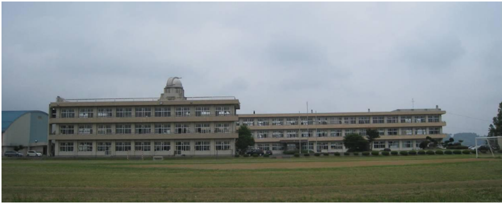
写真 18 岩ヶ崎高校校舎の全景
