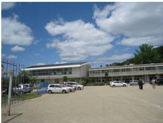
写真 16 上野目小学校 屋内運動場の全景
