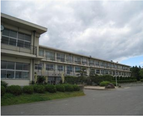
写真 6 築館中学校校舎の全景
