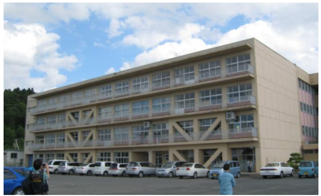
写真 24 栗駒中学校校舎棟の全景
