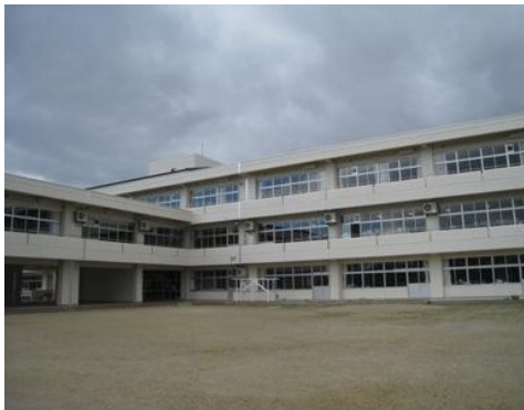
写真3 築館小学校校舎
