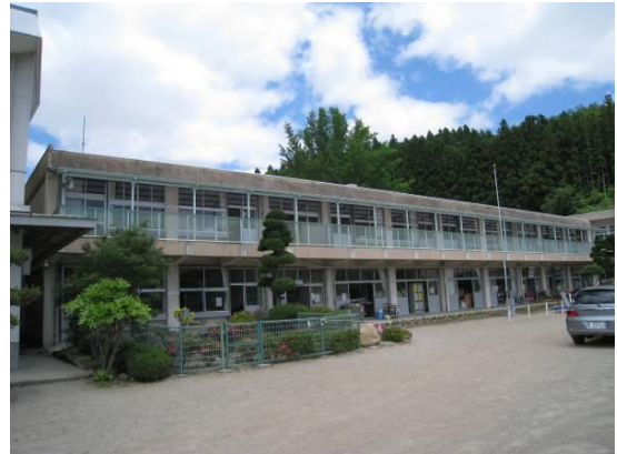
写真12 上野目小普通教室棟の全景
