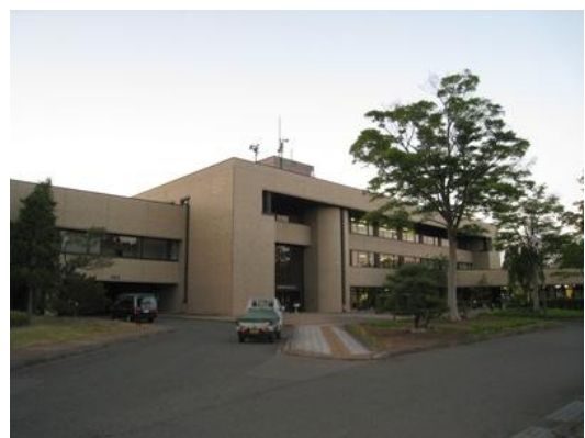
写真 11 奥州市胆沢総合支所の全景
