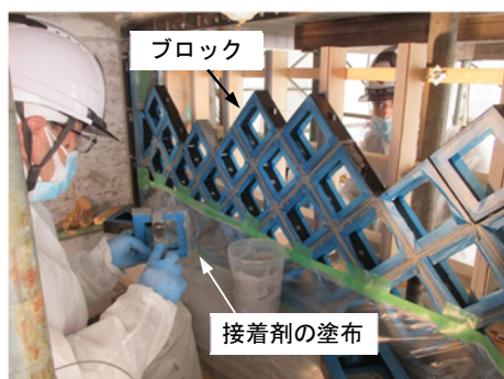
写真1 ブロック耐震壁の設置状況
