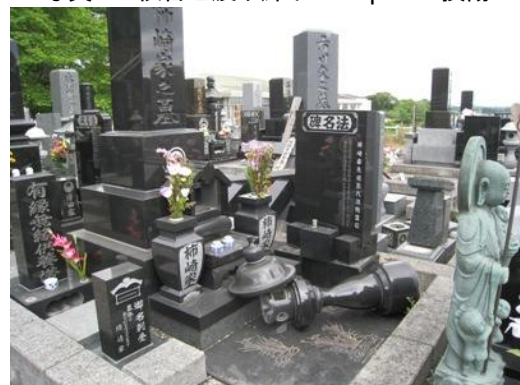
写真 5 転倒した石灯籠（墓石の転倒はない）
