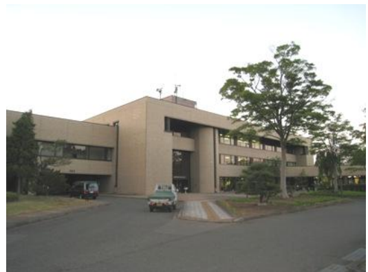
写真11 奥州市胆沢総合支所の全景
