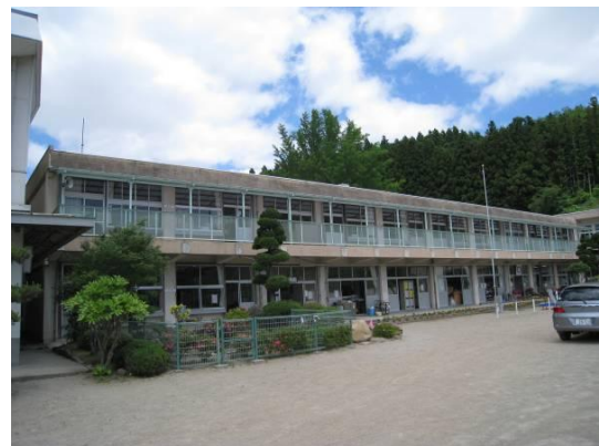
写真12 上野目小普通教室棟の全景
