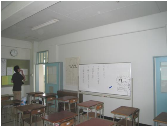
写真 25 教室の前後に出入口開口を設けた RC 補強耐震壁 (開口脇に付け柱あり)
