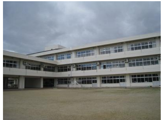
写真 3 築館小学校校舎
