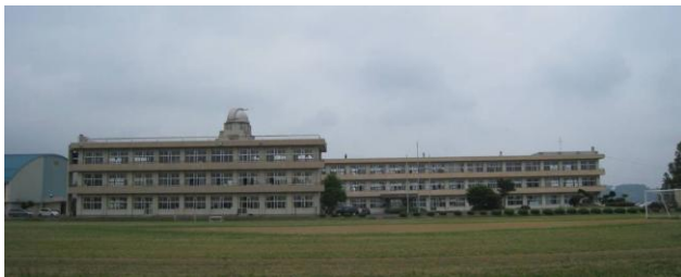
写真 18 岩ヶ崎高校校舎の全景
