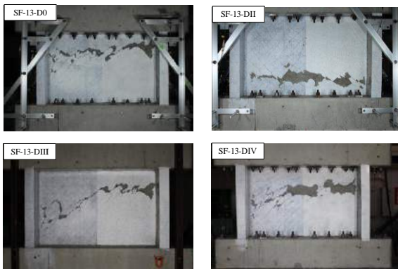
壁板のすべり破壊
